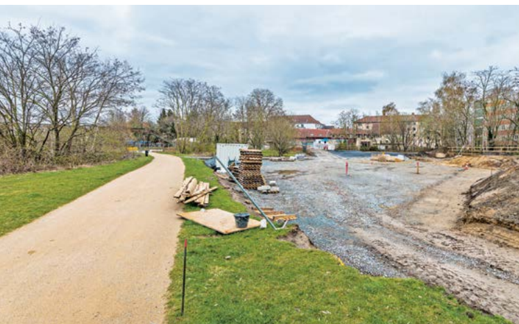
Noch eine Baustelle: die Freizeitplätze am Ringgleis
