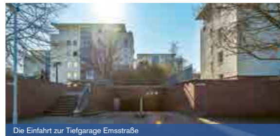
Die Einfahrt zur Tiefgarage Emsstraße
