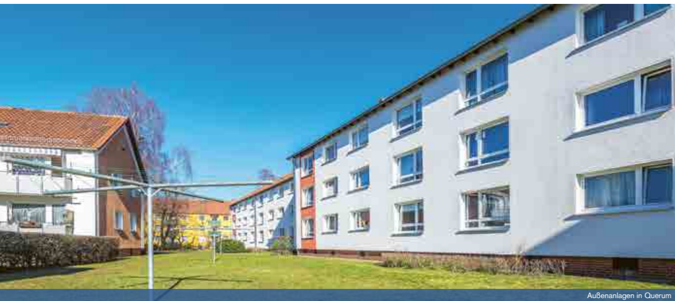
Außenanlagen in Querum
